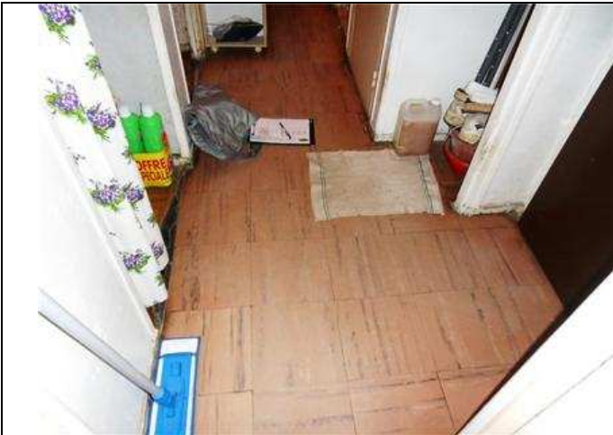
001 - Appartements - Entrée LOT0001 PH8 : Dalle, colle, ragréage PRE008
