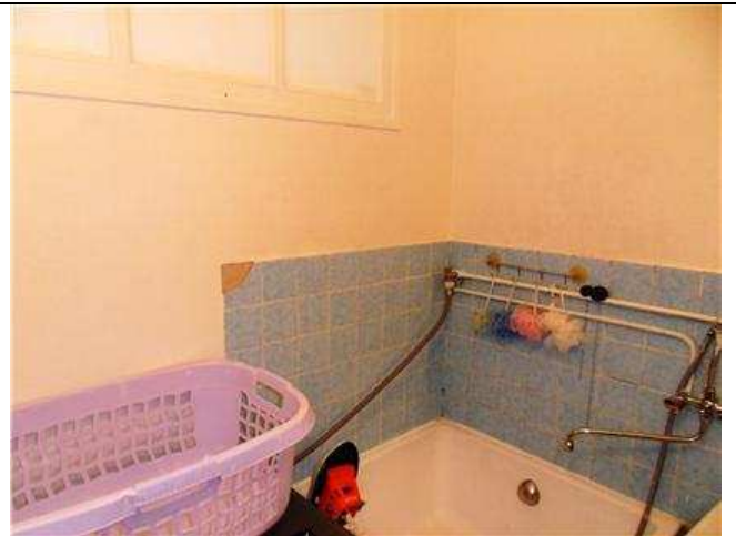
054 - Appartements - Salle d'eau LOT0301 PH9 : Colle céramique PRE009
